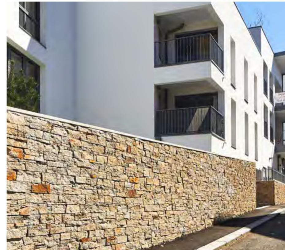
La plus grande résistance du marché à l'arrachement perpendiculaire (> ou égal à 400daN) grâce à l'ancrage breveté, obligatoire au-delà de 1,80m de hauteur.
