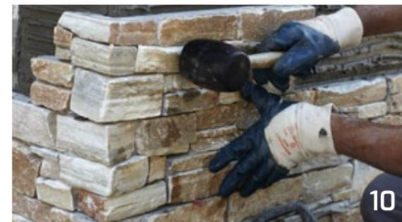
Après fixer le panneau et le vissage dans le mur, vous devez le frapper avec un marteau en caoutchouc pour le placer et éviter les bulles d'air entre le panneau et le mur, et assurer l'union.
