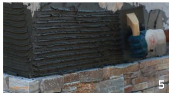
Avec le platoir denté, appliquez horizontalement une couche épaisse et lisse de 6-7 mm de mortier-colle. Pour que la première ligne reste plane, l'installation doit se réaliser sur un rail de métal ou sur un petit profil en « L » d'acier inoxydable. Le rail pourra être retiré une fois le mortier-colle est sèche et le profil d'acier inoxydable restera intégrée dans l'installation.
