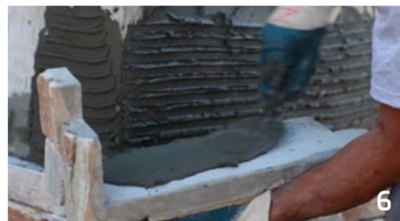
Appliquez aussi dans la partie arrière du panneau une couche épaisse de mortier-colle et distribuez-le horizontalement en utilisant la truelle dentée. Le mortier à utiliser doit être C2 ou C2-S1/S2 en intérieur et C2-S1/S2 pour les extérieurs.
