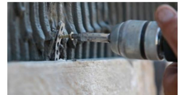
Insérez la vis à travers de la bande et fixez-les dans le mur. Le STONEPANEL® s'ajustera fermement.
