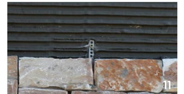
Mêmes procédures pour le reste des panneaux dans le rang et, pour que l'ancrage mécanique soit complètement couvert et n'interfère pas avec l'installation des panneaux.
