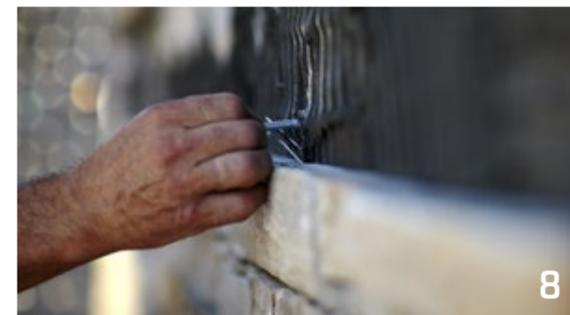
Chaque panneau exige une fixation mécanique. Percé les trous pour placer les vis d'acier inoxydable et insérez les chevilles dans le mur comme aide pour l'ancrage.
