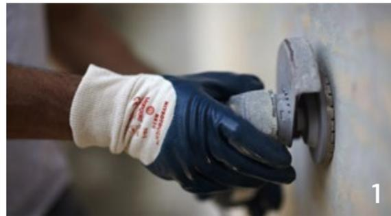
Les murs doivent être propres et dépoussiéré, et livres de saleté, huile, peinture, etc. Les trous ou fissures doivent être remplis de laitance de ciment. Le mur supportera un poids au-dessous des 80-95 kg/m<sup>2</sup>. Le système doit être installé uniquement quand il n'y a pas de signes d'humidité dans la surface, sauf ceux causés par la condensation.
