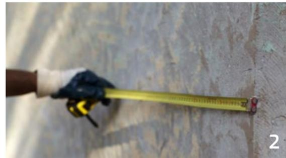
Mesurez la zone avant de commencer l'installation. Il est recommandé d'ajouter un minimum des 5 % pour les coupes possibles.
