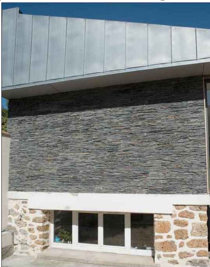
■ Pas à pas, pose parement pierre naturelle sur pignon. Photos Cupa Stone
